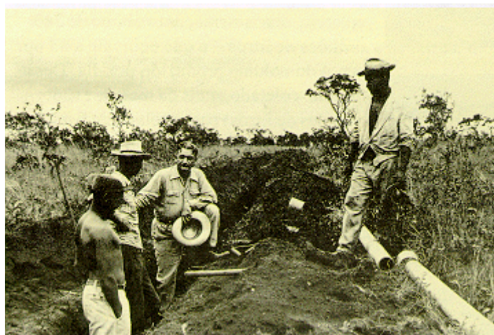
Figura 5 – Primeiras canalizações de água em Brasília
