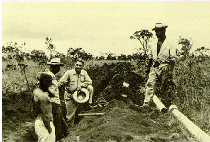
Figura 1 – Primeiras canalizações de água em Brasília
