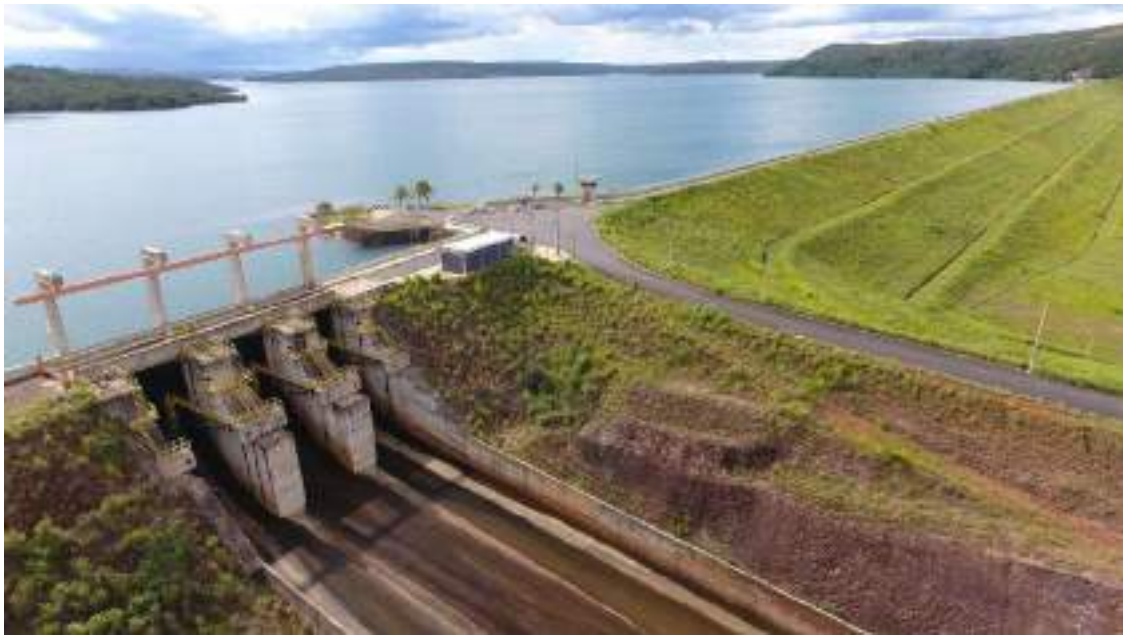
Figura 11.8 - Reservatório da UHE Corumbá IV. Fonte: Corumbá Concessões.
