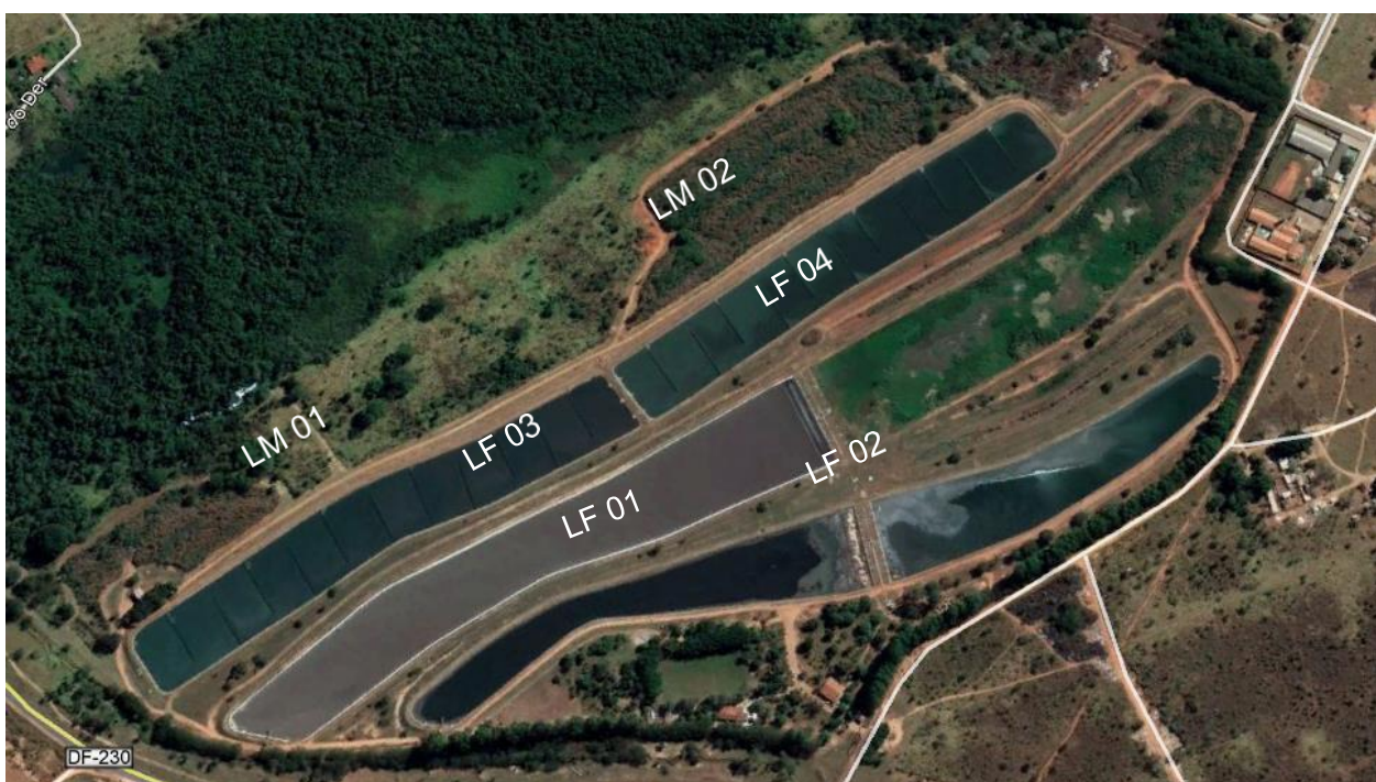
Figura 12: Vista aérea da Estação de Tratamento de Esgotos Planaltina
