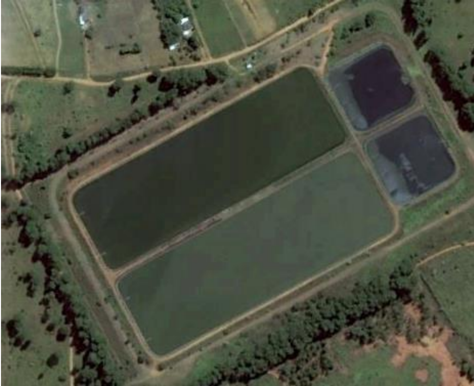
Figura 23: Detalhes da ETE Brazlândia. (Fonte: Google Earth)
