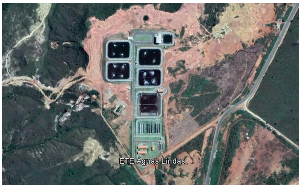
Figura 24: Detalhe da ETE Águas Lindas. (Fonte: Google Earth)
