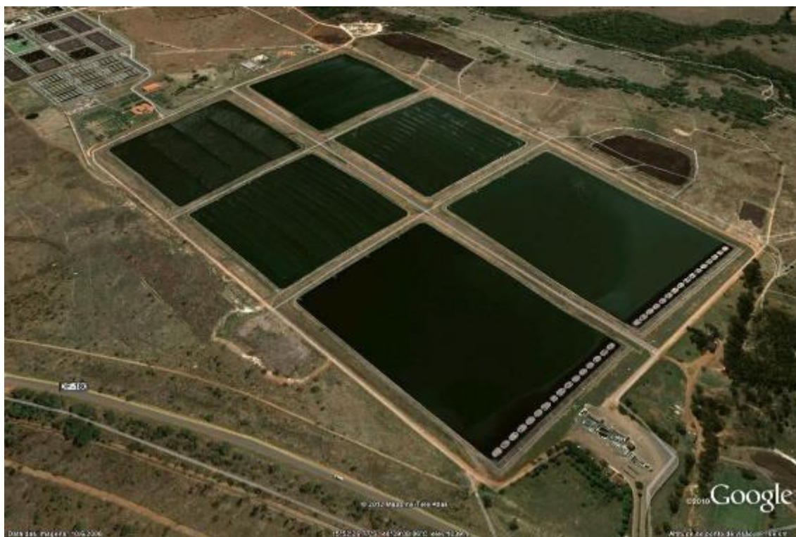
Figura 22: Estação de Tratamento de Esgotos Samambaia. (Fonte: Google Earth)
