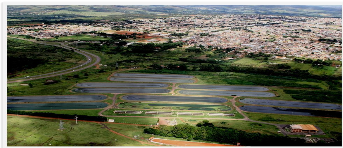
Figura 17: Detalhe da ETE Alagado. (Fonte: Caesb)
