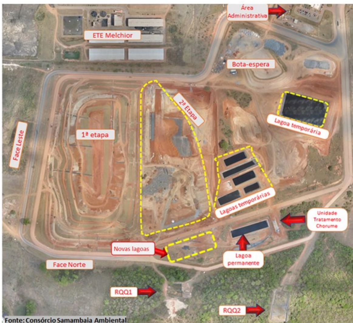
Figura 1 - Vista aérea do Aterro Sanitário de Brasília em 27/02/2020.
