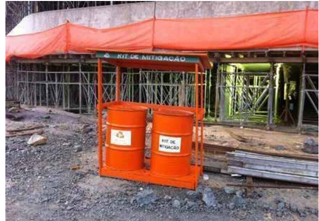
Figura 65 Kit mitigação de vazamentos disposto na frente de serviço. Fonte: Rosa (2013)
