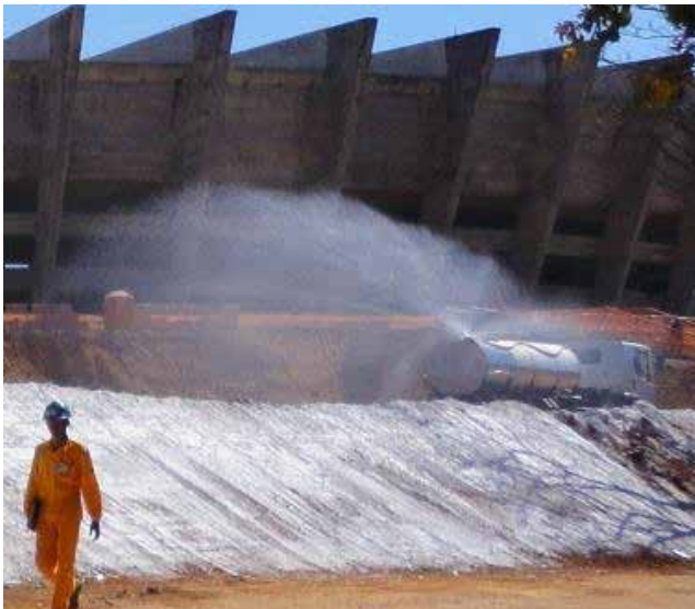
Figura 37 Aspersão de água para controle de poeira em via de circulação de veículos. Fonte: Rosa (2013)
