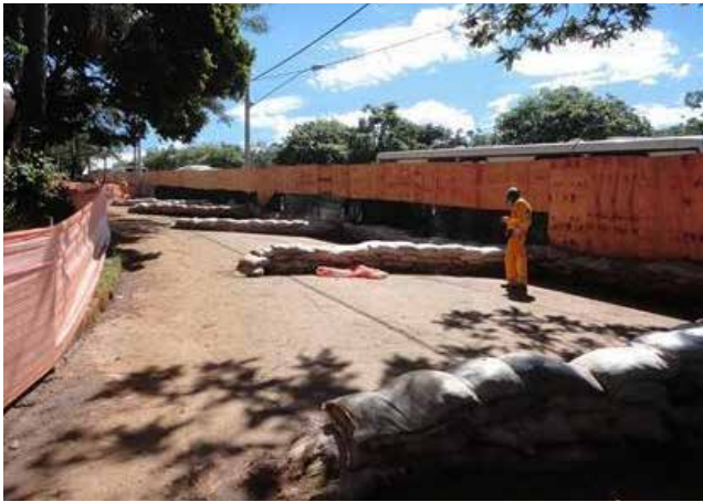
Figura 55 Dispositivos de retenção de sedimentos com barreiras de sacarias. Fonte: Rosa (2013)
