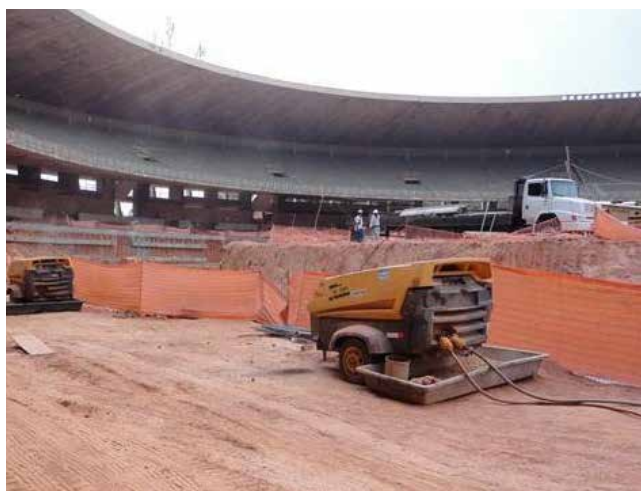
Figura 62 Bandeja plástica sob compressor movido a diesel. Fonte: Rosa (2013)
