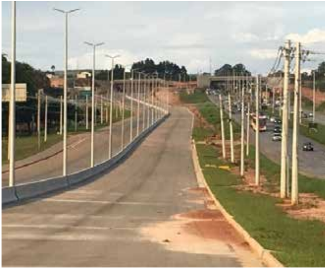
Figura 16 Exemplo de obras lineares na Ligação do Torto Colorado. Fonte: Rosa (2019)
