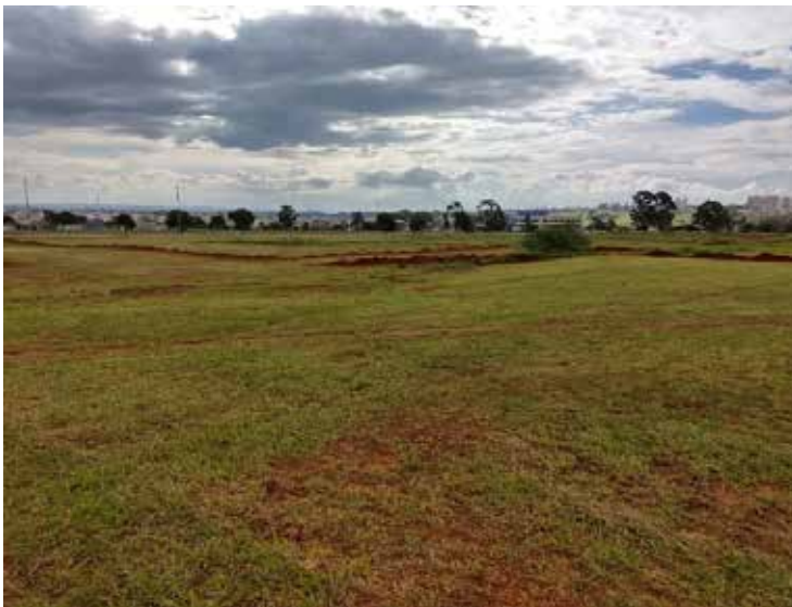
Figura 7 Abertura de valas para assentamento de rede de distribuição de água em futuro setor urbano. Fonte: SDU/Adasa (2019)
