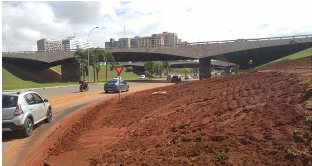
Figura 1 Obra de recomposição de gramado em talude na região central de Brasília (Avenida W3). Fonte: SDU/ADASA (2018)
