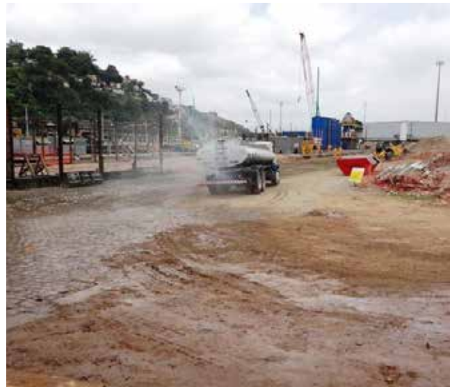
Figura 38 Controle de poeira na entrada da obra. Fonte: Rosa (2013)
