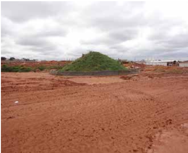
Figura 33 Estoque de solo orgânico estabilizado. Fonte: Rosa (2013)
