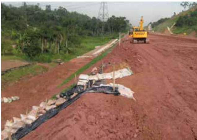
Figura 57 Lombada de solo na crista do talude provisório e descidas hidráulicas estabilizadas com sacarias. Fonte: DERSA (2009 apud Almeida Junior, 2011)
