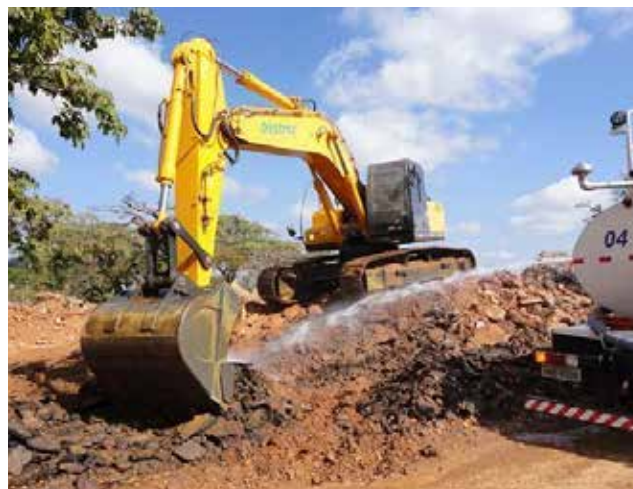
Figura 40 Umedecimento de material de demolição de piso durante sua remoção para controle de poeira. Fonte: Rosa (2013)
