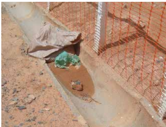
Figura 49 Sacarias dispostas nas calhas para retenção de sedimentos. Fonte: Rosa (2013)
