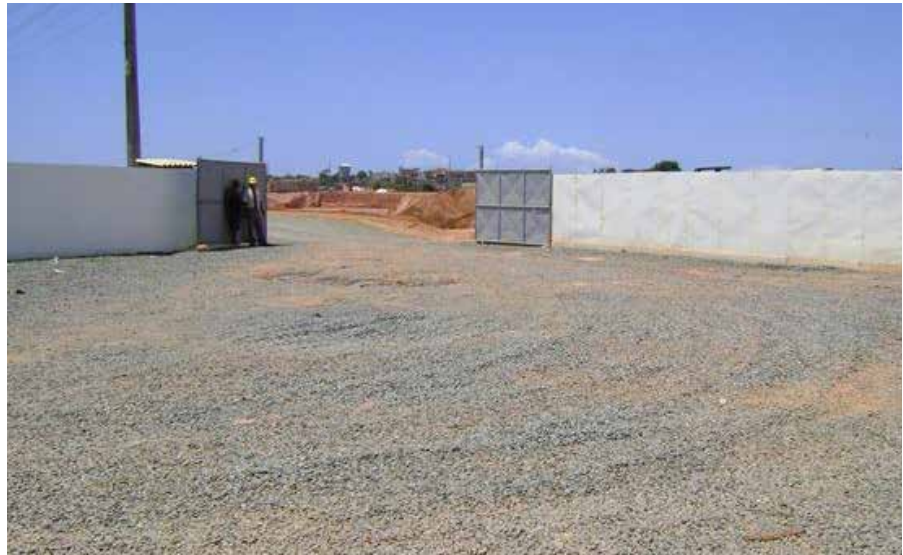
Figura 25 Acesso da obra estabilizado com camada de brita. Fonte: Rosa (2013)
