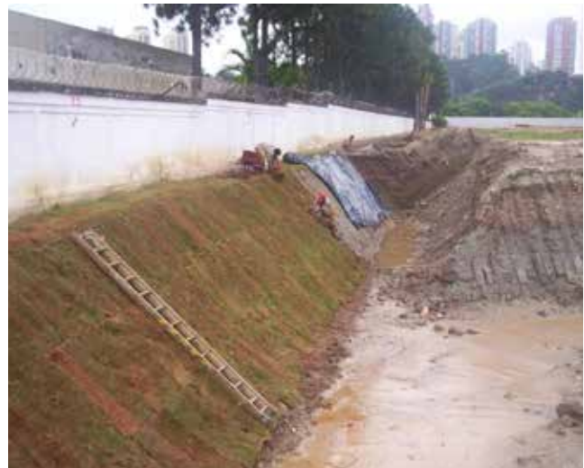
Figura 34 Estabilização da superfície do talude. Fonte: Rosa (2011)
