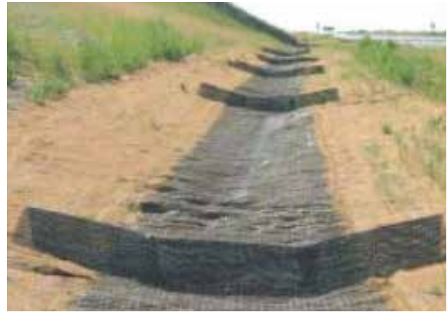
Figura 56 Barreiras de sedimentos com cercas de membrana geotêxtil em calha estabilizada com manta de fibra vegetal. Fonte: LANDCON (2004)
