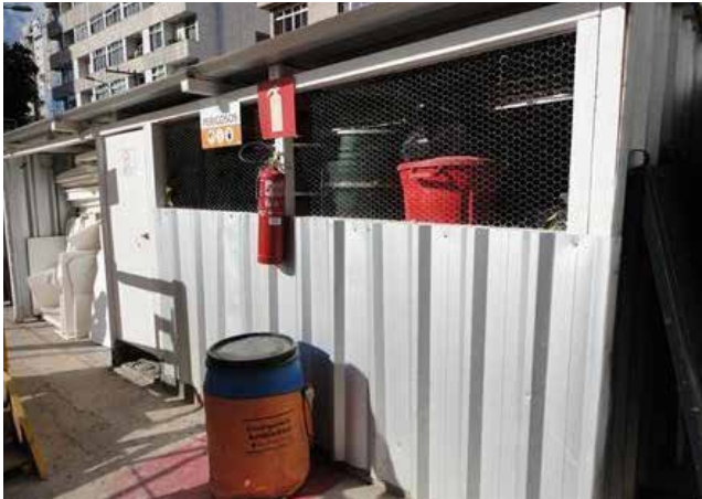
Figura 64 Depósito de produtos químicos. Fonte: Rosa (2013)
