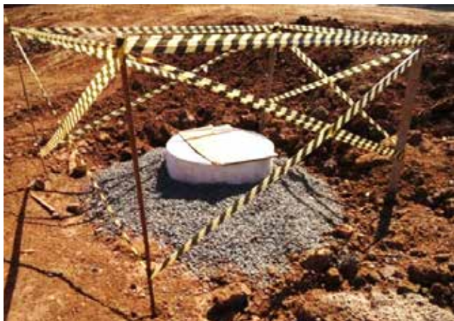
Figura 60 Proteção das entradas da rede de águas pluviais em execução contra o acesso de sedimentos da obra. Fonte: Rosa (2013)
