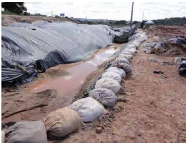
Figura 47 Calha pluvial provisória revestida, cuja lona é fixa na lateral pela massa das sacarias, as quais atuam restringindo a vazão de entrada do escoamento e retendo sedimentos. Fonte: Rosa (2013)
