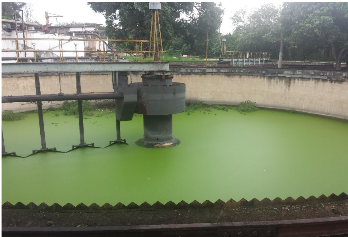
Foto 4 – Tanque ETE Antiga (Desativada)
