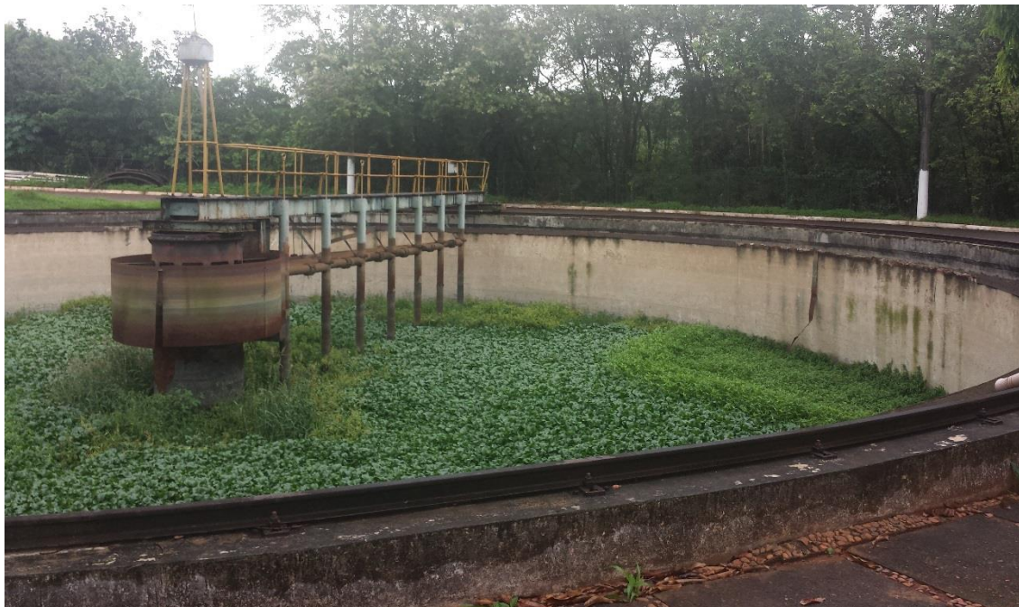
Foto 5 – Tanque ETE Antiga (Desativada)
