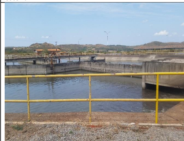
Foto 13 – Reator fora de carga.
