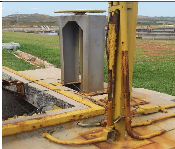
Foto 19 – Equipamentos oxidados.
