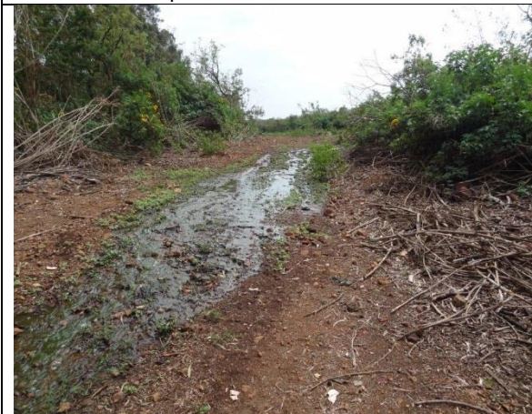
Foto 9 – Extravasamento dos canais de escoamento superficial.
