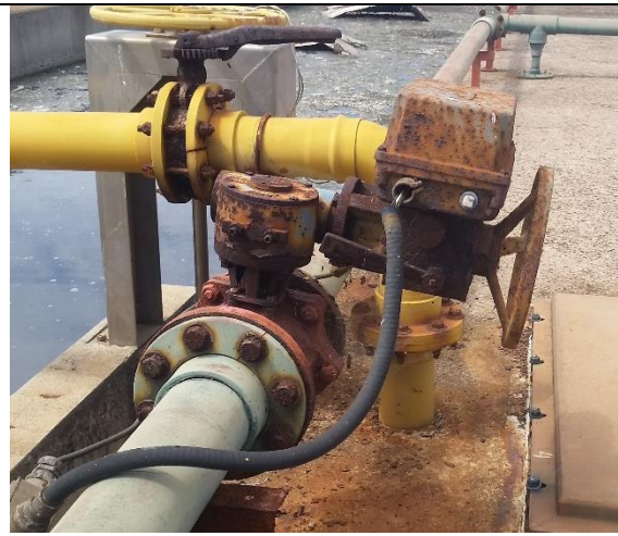
Foto 18 – Equipamentos oxidados.
