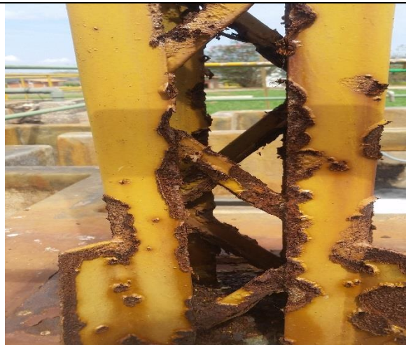
Foto 17 – Equipamentos oxidados.
