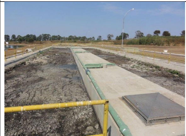
Foto 6 – Acúmulo de sujeira nos RAFAs.
