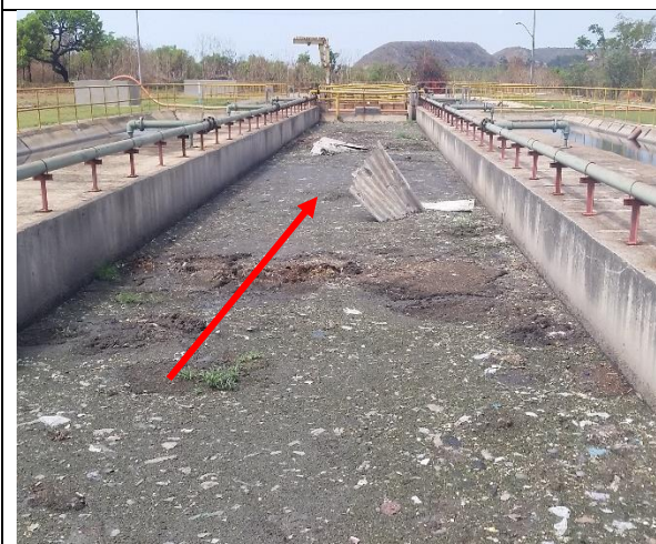
Foto 13 – Reator fora de carga.
