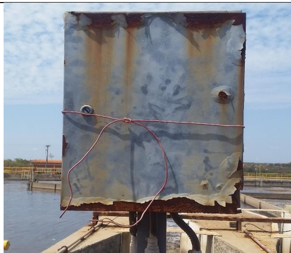
Foto 20 – Equipamentos oxidados.
