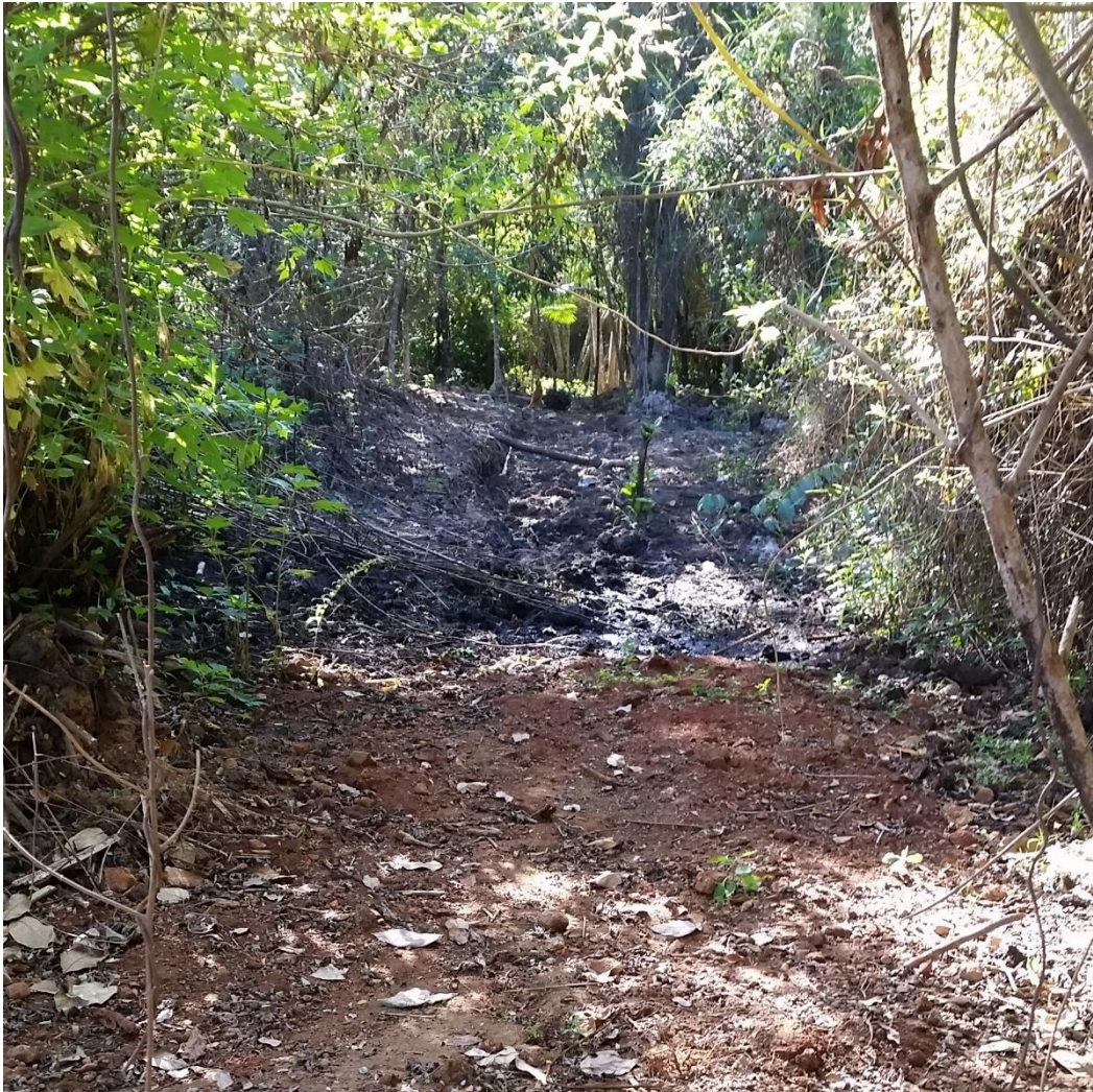
Foto 2 – Obras de implantação da tubulação de coleta de esgoto
