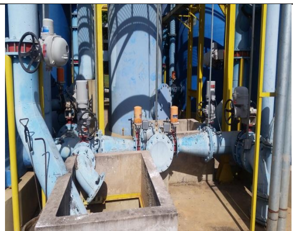
Foto 20 – Atuadores trocados e operando.
