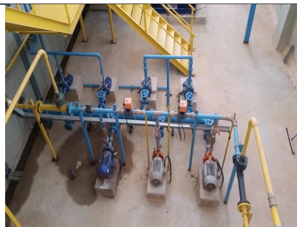
Foto 08 – Vazamento em um dos filtros permanece.
