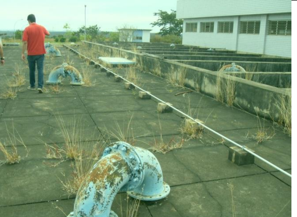
Foto 13 – Teto da câmara de contato com sinais de falta de manutenção (RF/COFA/004/2015).
