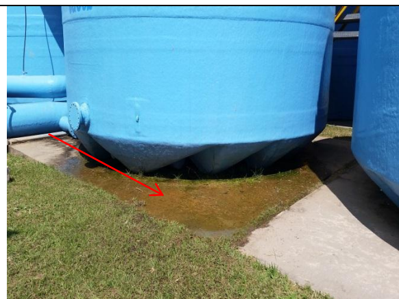
Foto 08 – Vazamento em um dos filtros permanece.
