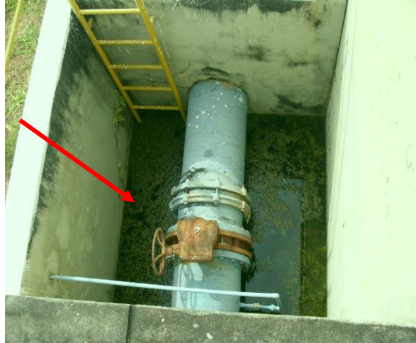
Foto 11 – Acúmulo de água em caixa de concreto (RF/COFA/004/2015)
