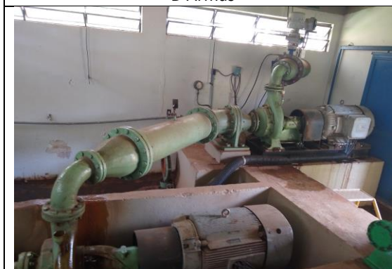
Foto 3 – Motores ligados em série
