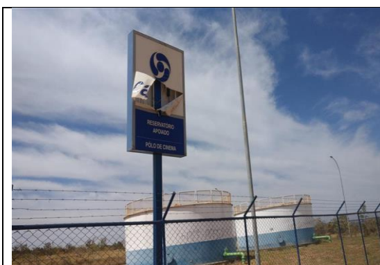
Foto 13 – Entrada do Reservatório Apoiado Polo de Cinema
