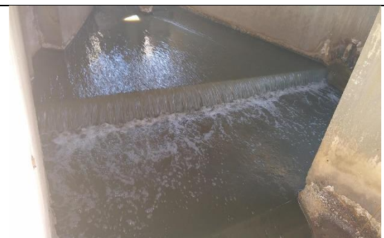
Figura 3 – Zona de mistura do coagulante
