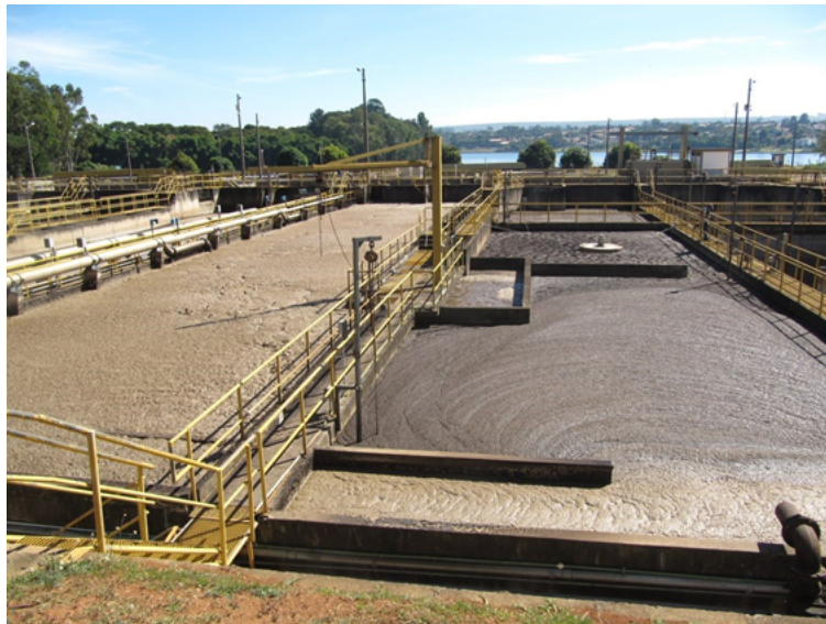
Figura 9 - ETE Brasília Norte.
