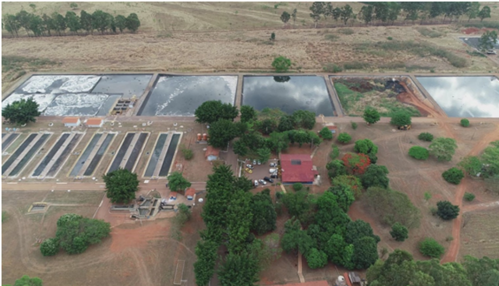
Figura 14 - ETE Recanto das Emas.
