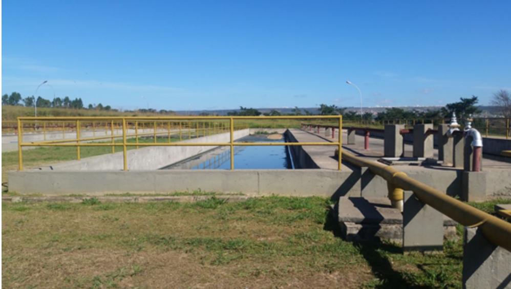
Figura 18 - ETE São Sebastião.
