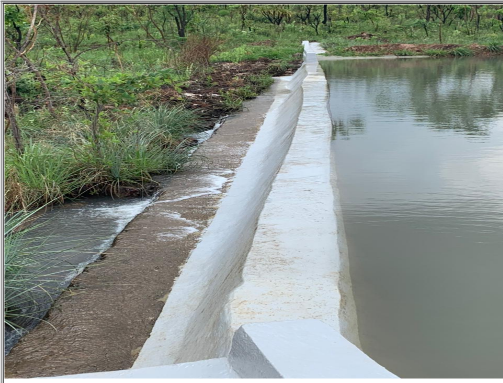
Foto 3 - Captação Ponte Terra 3
