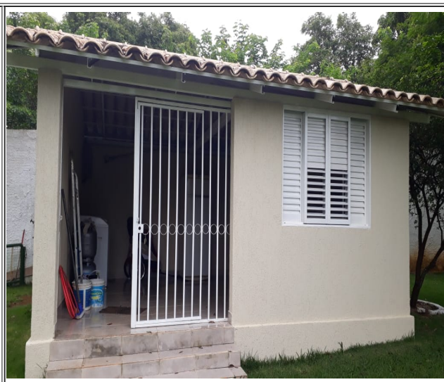
Foto 2 - Instalações do reservatório de água
