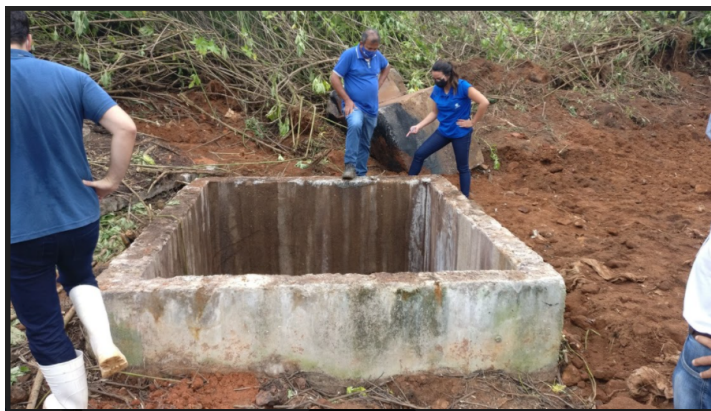
Fig. 05: Caixa de interligação. Ao fundo, pedra que obstruía a rede antiga.
