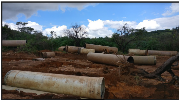
Fig.02: Tubulação PFV retirada do leito.
