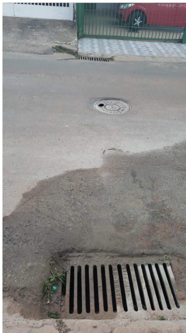
Foto 6 - Terceiro conjunto de tampas, em frente à casa 8/10.
