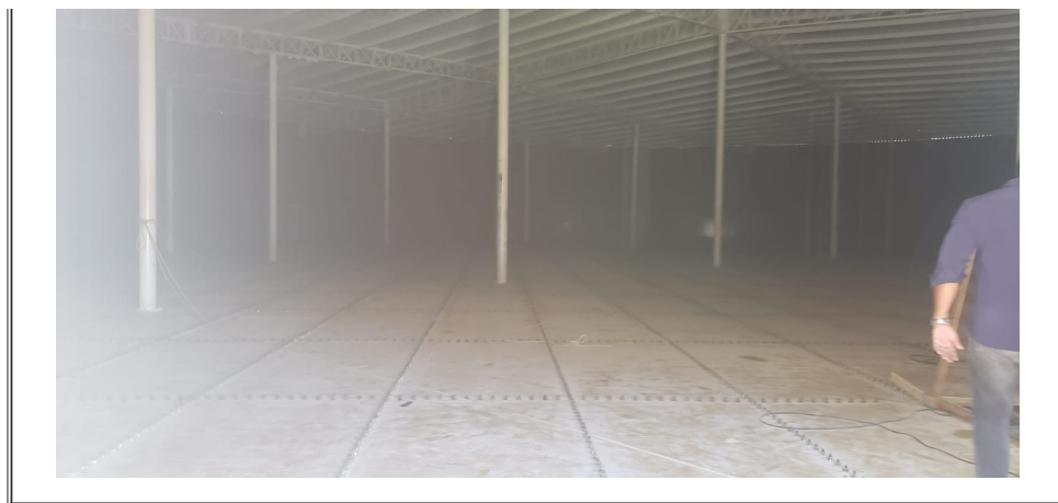
Foto 4 - Reforma do reservatório (vista por dentro)
