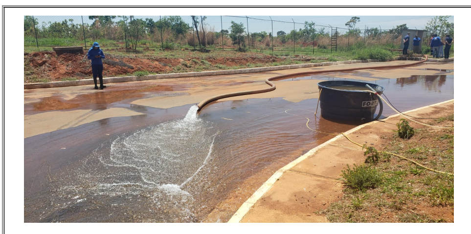
Foto 2 - Esvaziamento da adutora
