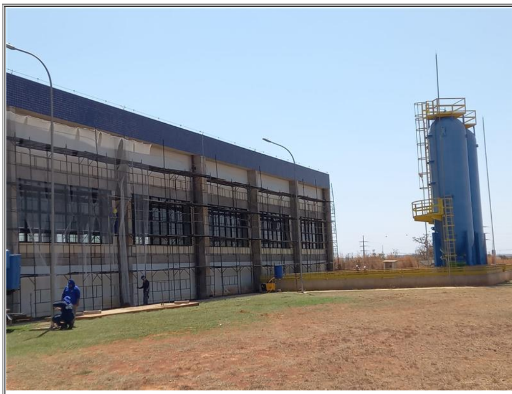
Foto 3 - Pintura da Elevatória de Água Tratada
