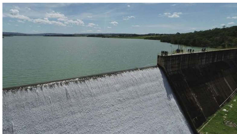
Foto 1 - Barragem do Descoberto
