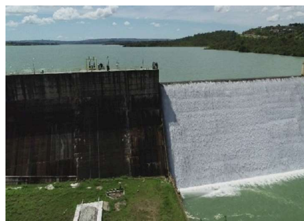
Foto 2 - Barragem do Descoberto
