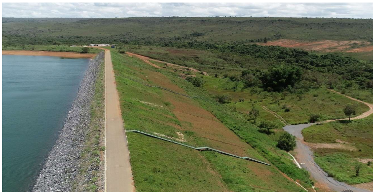
Foto 17 - Construção de escada de acesso aos instrumentos de monitoramento
