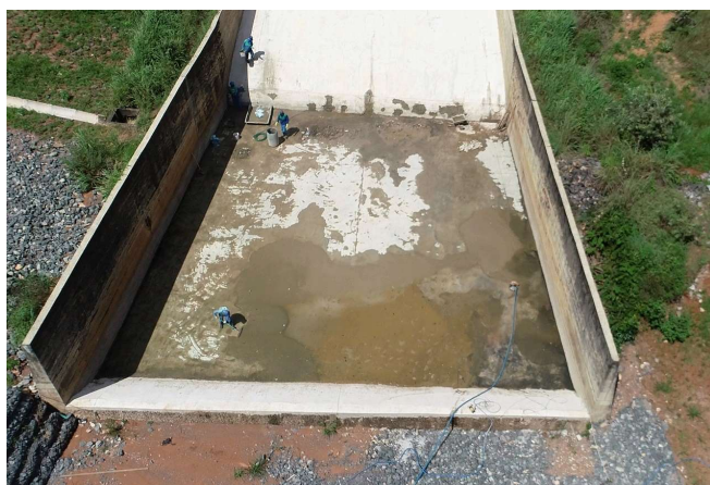
Foto 7 - Reforma do vertedouro
