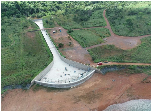
Foto 5 - Reforma do vertedouro de Santa Maria
