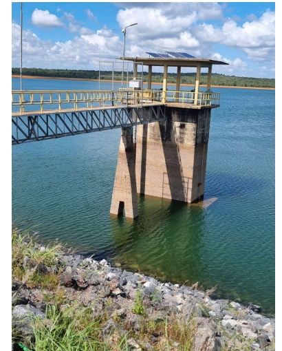
Foto 16 - Caixa de concreto para proteção de duas válvulas nova adutoras da saída do reservatório e remoção de toda a vegetação | jusante e plantio de grama batatais.
