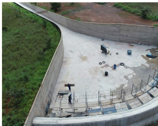
Foto 6 - Reforma do vertedouro de Santa Maria
