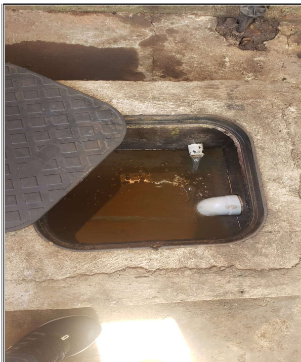
Foto 3 - Simulação de despejo de água de chuva na caixa de inspeção de águas pluviais
