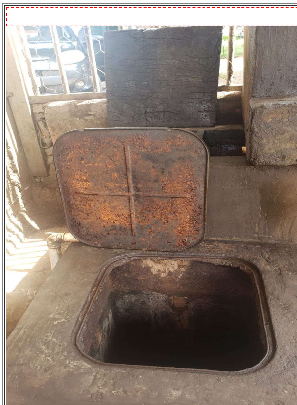
Foto 1 - Caixa de inspeção de esgoto
