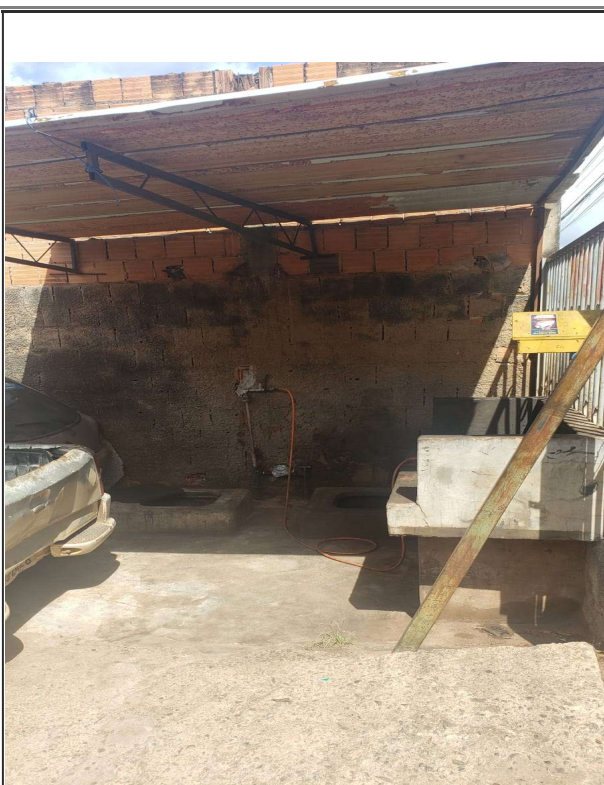
Foto 2 - Local onde estão instaladas a caixa de inspeção de esgoto (à direita) e de águas pluviais (à esquerda)
