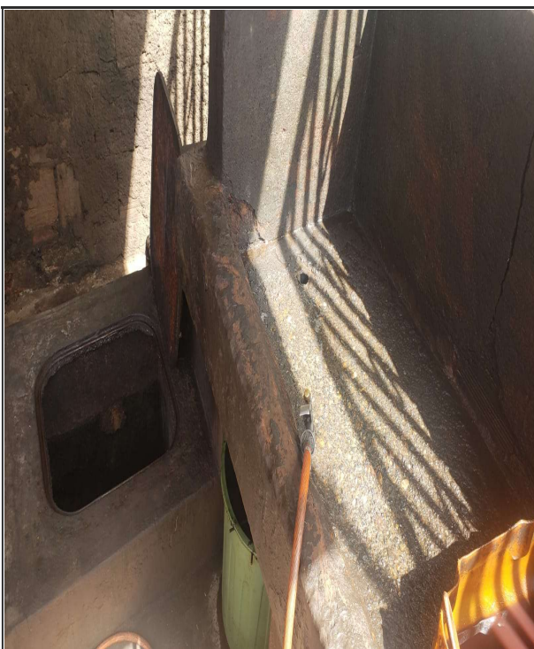
Foto 4 - Caixa de inspeção de esgoto
