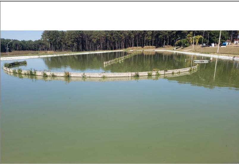
Foto 5: Lagoa de tratamento de esgoto em funcionamento
