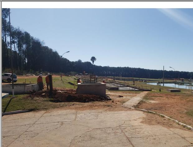
Foto 2: Construção de novos RAFAs (Reatores Anaeróbios de Fluxo Ascendente)
