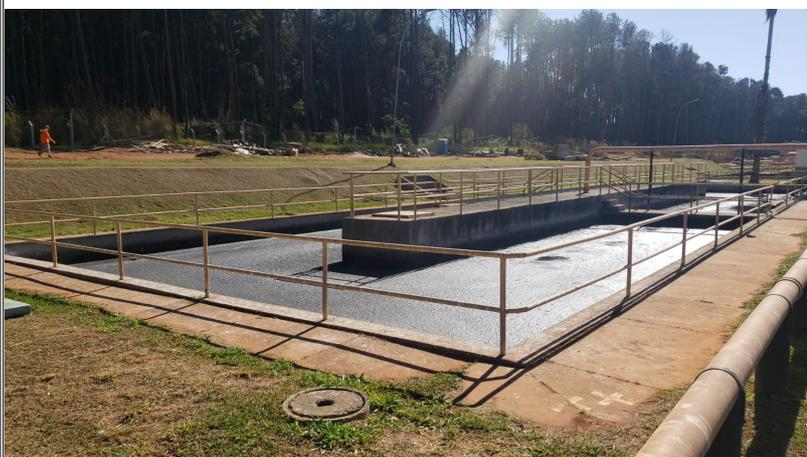
Foto 3: RAFA (Reator Anaeróbio de Fluxo Ascendente) em funcionamento
