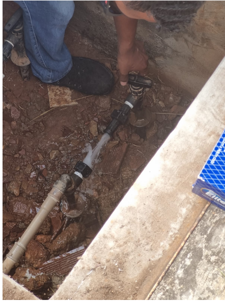
Foto 4 - Verificação visual da presença de água pressurizada
