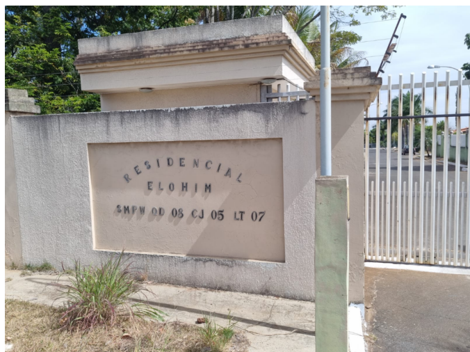
Foto 1 - Entrada do condomínio onde houve denúncia de falta d'água
