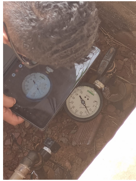
Foto 5 - Teste de pressão da água
