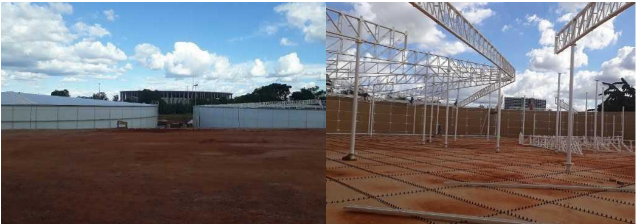
Figura 43 - Fotos da obra das câmaras do RAP.PPL.001.
