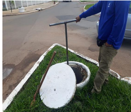
Figura 28 - Manobra na rede de distribuição.
