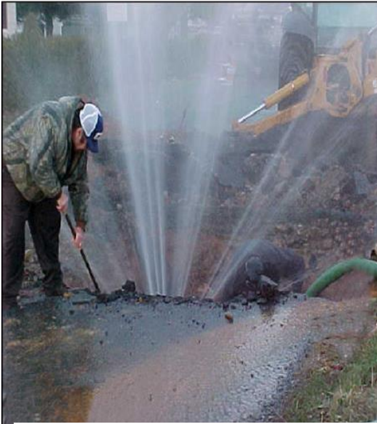
Figura 26 - Efeito da pressão em um vazamento.
