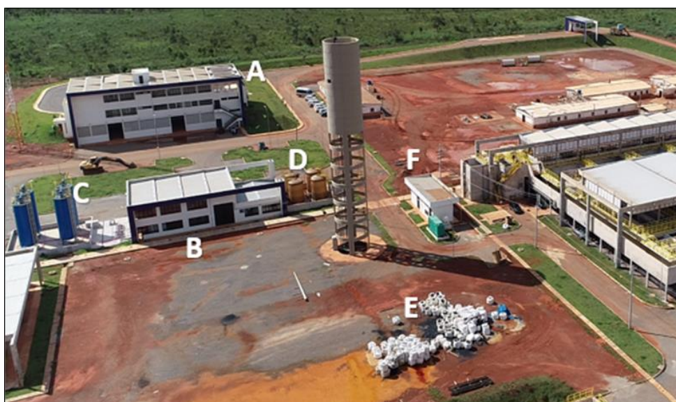
Figura 2 - A) Prédio administrativo; B) Casa de química; C) Reservatório de geocálcio; D) Tanque de sulfato férrico; E) Estoque de antracito; F) Subestação SE 02.
