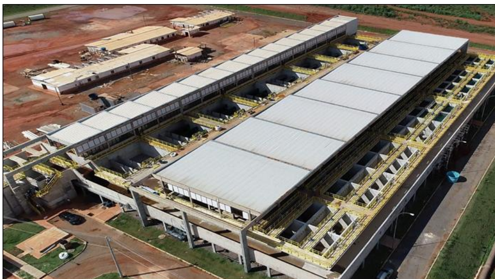
Figura 1 - Detalhe do módulo de tratamento de água da ETA Corumbá
