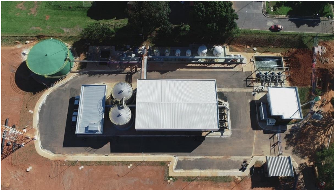
Figura 8 – Estação de Tratamento de Água do Gama (ETA Gama)
