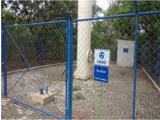
Figura 6 – Poço EPO.001 (Núcleo Rural Monjolo)
