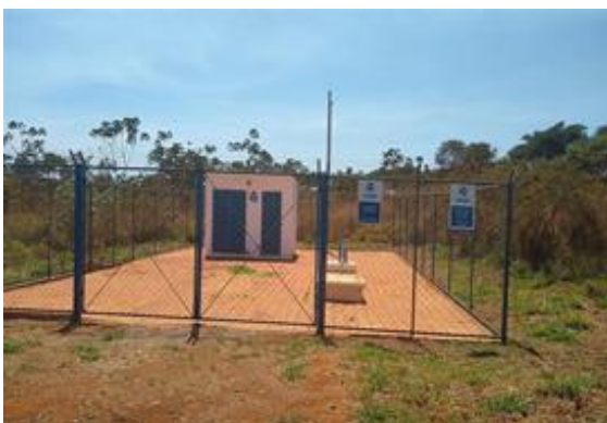
Figura 4 - EPO.NJ2.003/UTS.NJ2.003 (Núcleo Rural Capão Seco)
