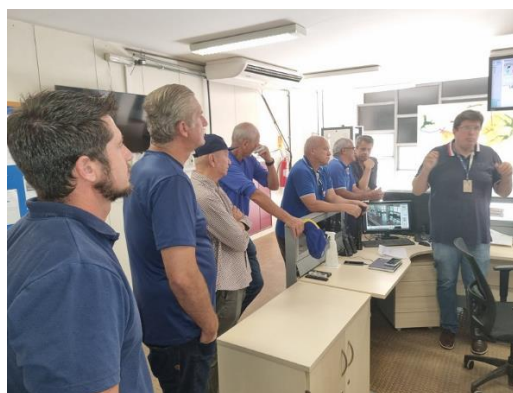
Figura 47- Sala de operação da Estação Elevatória de Água Bruta do Descoberto
