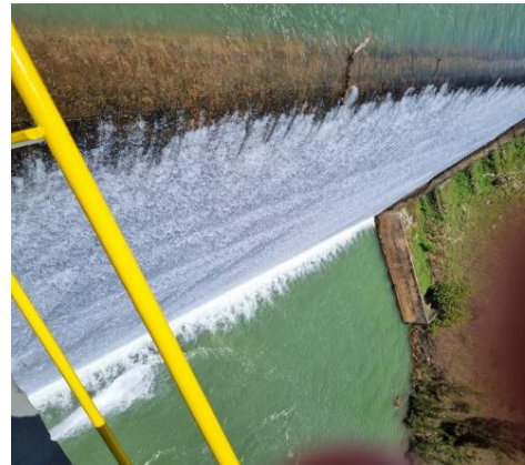
Figura 53 - Água da Barragem sendo vertida para o rio remanescente por atingir sua capacidade máxima
