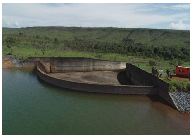
Figura 62 - Vertedouro da barragem de Santa Maria
