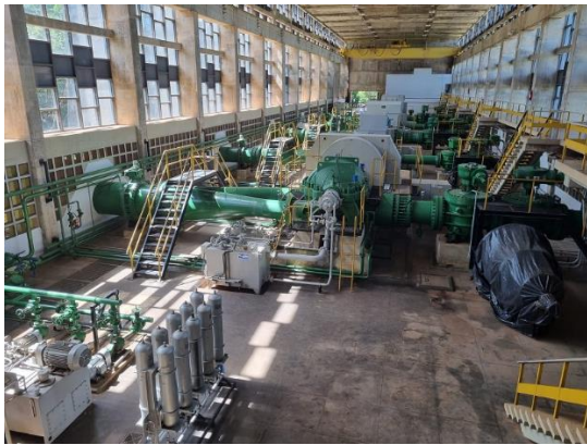
Figura 50- Motores de bombeamento de água
