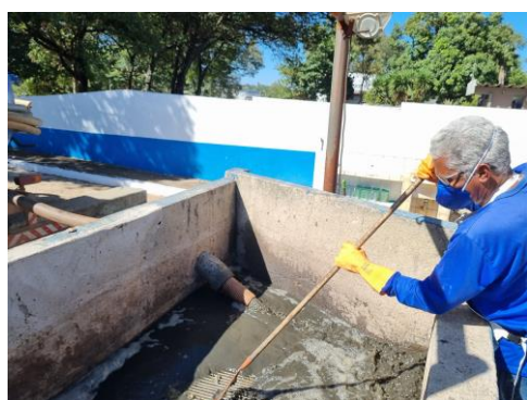
Figura 22 - Operador da CAESB limpando o gradeamento de chegada do lodo.
