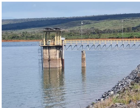
Figura 61- Reservatório de Santa Maria
