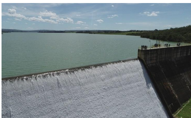
Figura 46- Barragem do Descoberto
