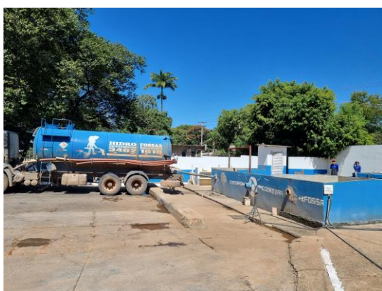
Figura 20 - Caminhão limpa fossa em processo de descarte, na unidade da ETEB Sul.
