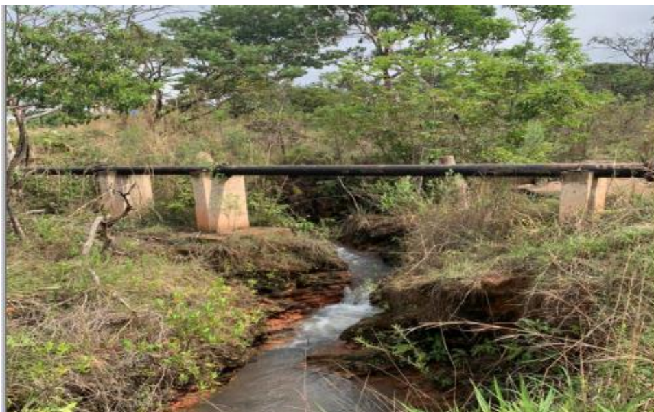
Figura 10 - Adutora Olho d'Água.
