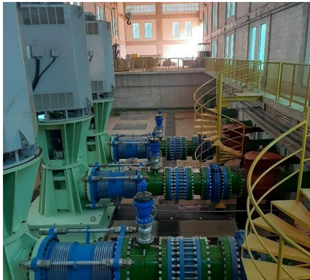
Figura 8 - Conjuntos moto-bomba da Estação Elevatória.
